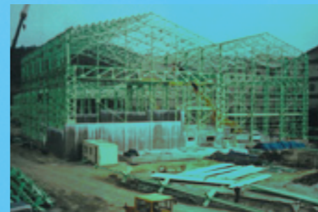
→ 포항 주물 2공장 공사현장
